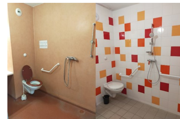
Rénovation des salles de bain (avant/après)
